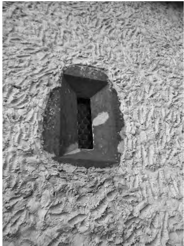
Figura 9: Ventana del siglo XVIII, abierta en el muro sur. Se observa también la capa de cemento de revoco aplicada a toda la pared, en este caso en época actual.
