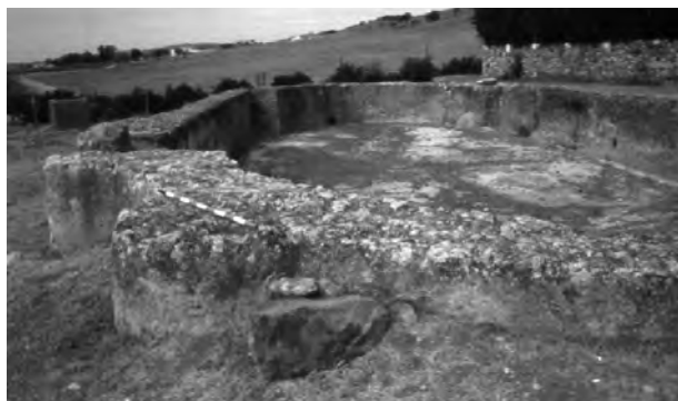
Lámina XV: La gran cisterna de Las Pitás, con contrafuertes semicilíndricos en cada uno de los dos ábsides de remate de sus extremos.
