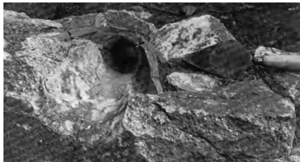
Lámina XVII: Cisterna griega de Laurión (HEALY, 1978: Lám. 43) en la que se observa un cuello de ánfora aplicado para provocar un chorro de lavado a presión, tal y como hemos constatado en la cisterna biabsidial de Las Pitás.
