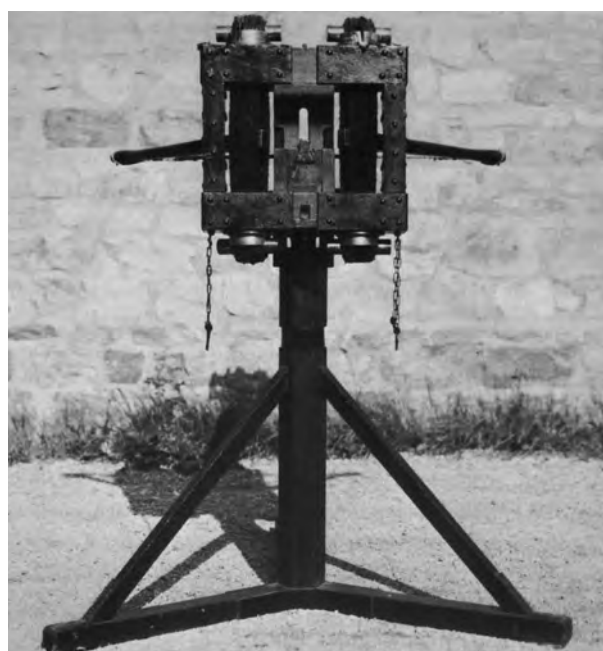
Lámina III: Reconstrucción de la catapulta de Ampurias. Vista frontal (SCHRAMM, 1918).
